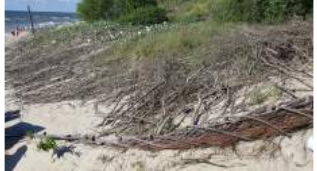
Medienos naudojimas kranto sutvirtinimui
